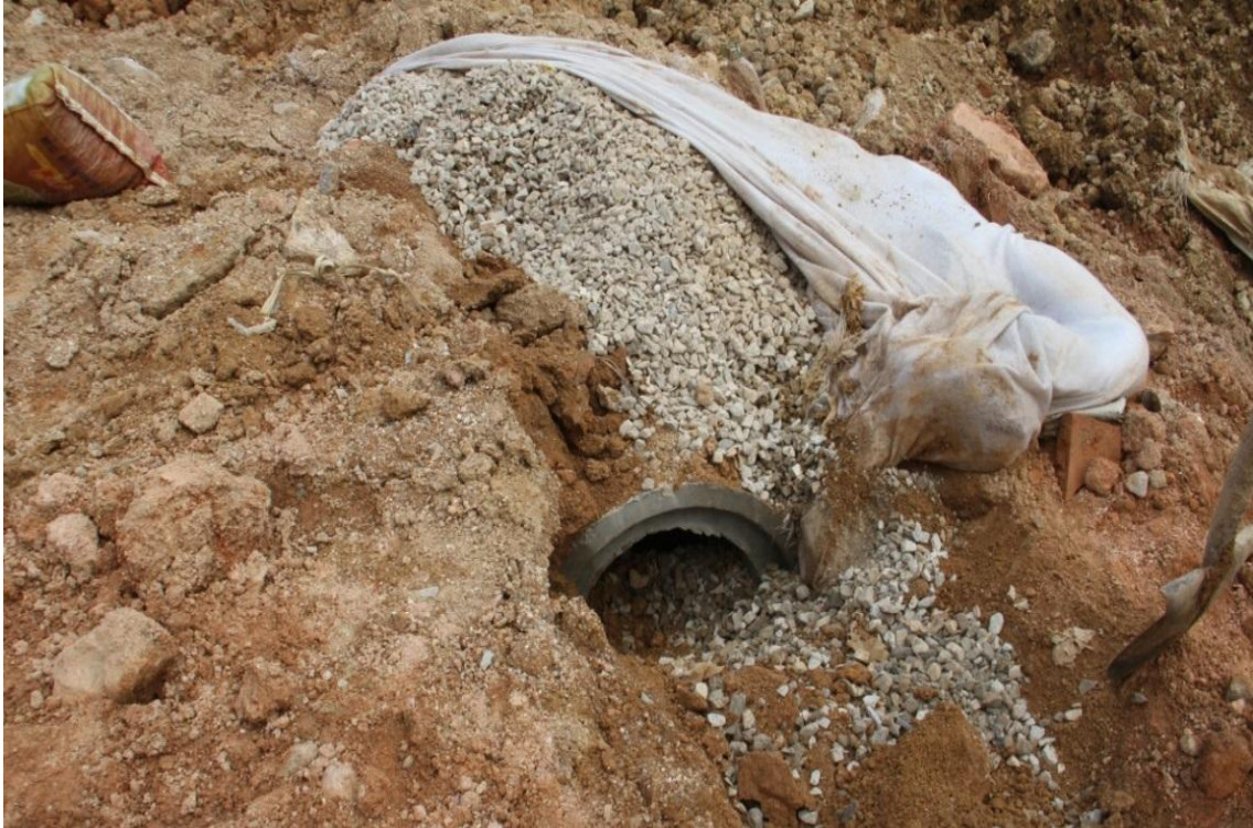
图 8 盲沟中的花管铺设情况图
