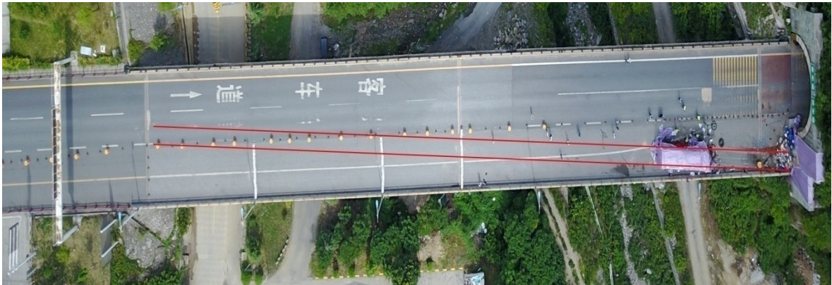
图 2 事发桥面航拍图
